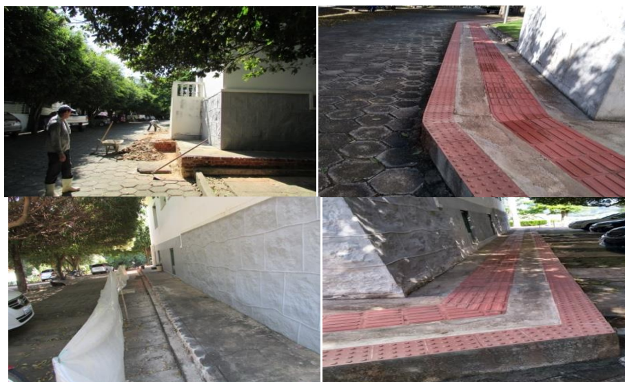
Figura 9. Adequação de Instalações (IFES/Campus de Alegre). Fonte: própria
