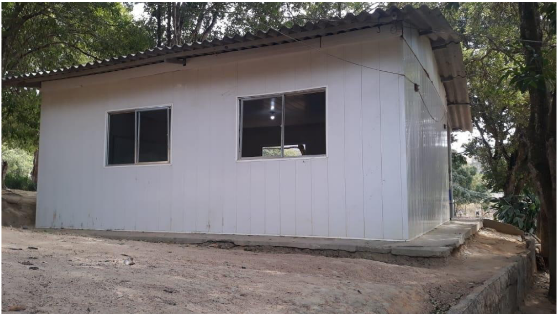
Figura 11: Sala modular construída para atender o Ensino Médio
